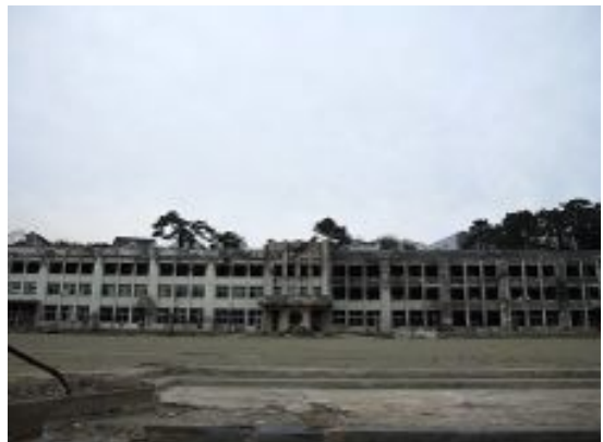
▲大川小学校とは対照的に、震災時児童たちは津波前に裏の日和山に逃げて全員助かった石巻市立門脇小学校。
