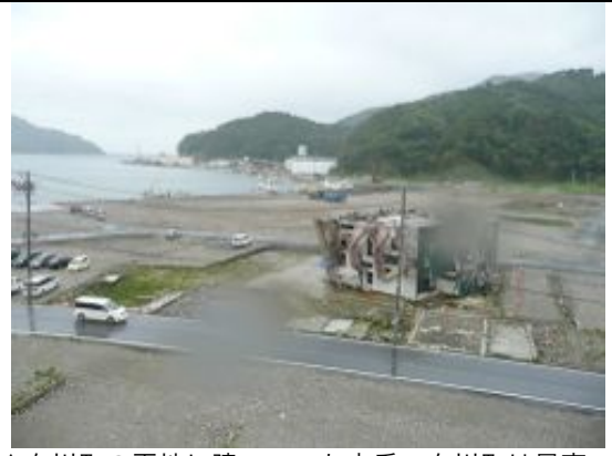
▲女川町の平地に建っていた交番。女川町は最高で 30 数メートルの津波が襲い、町の建物や被災を受けた住民のほとんどが引き波によるものとされており、行方不明者が多い。
