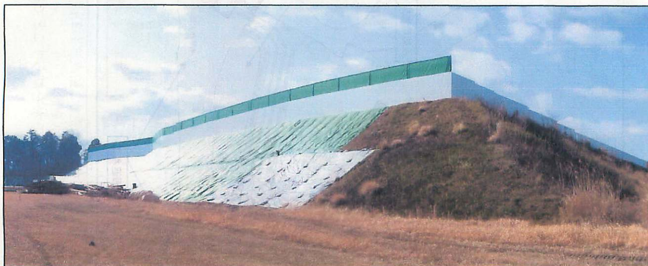
仮囲い設置状況
