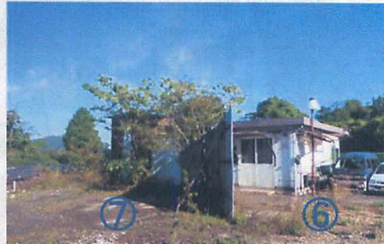
⑥ ⑦ 倉庫、キュービクル
