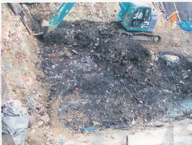
有害物掘削工（B区画）
