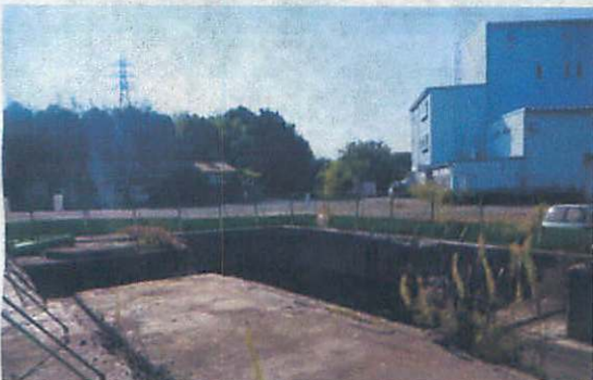
⑤ 南側焼却炉基礎
