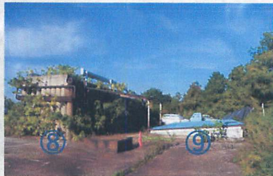
⑧ ⑨ 焼却炉スロープ、防火水槽
