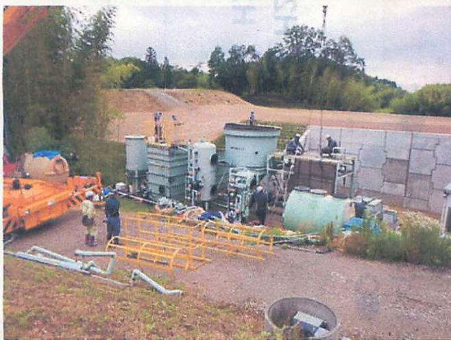
(旧施設 移設作業)
