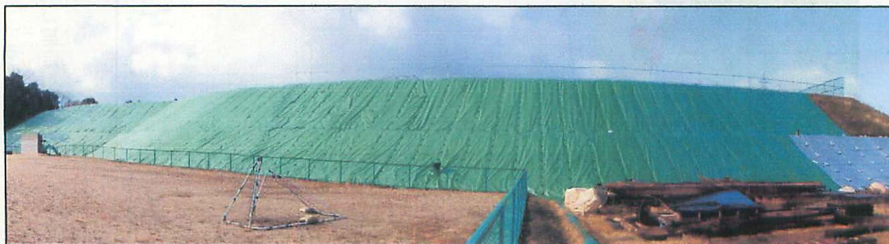
防草シート設置状況
