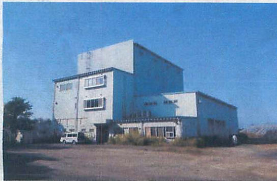
① ガス化溶解炉建屋
