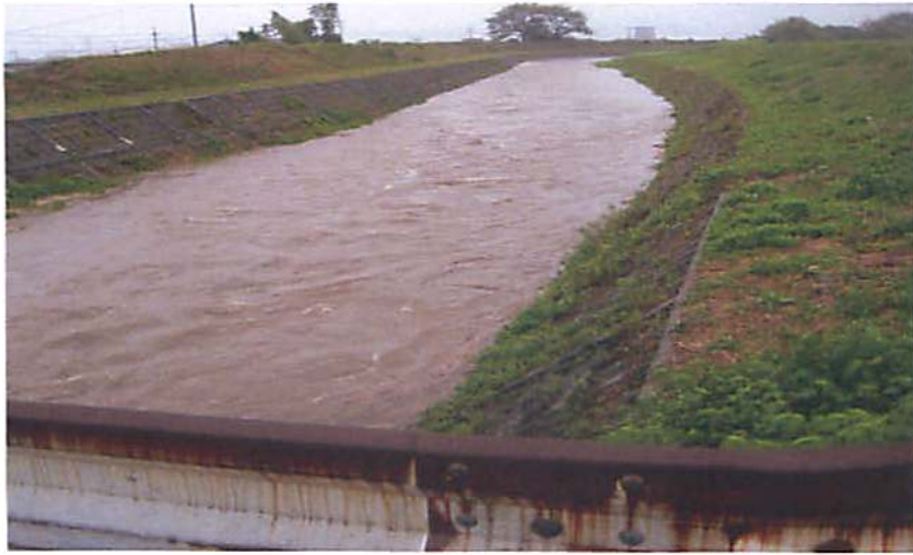
金勝川の現況（目川地先 天井川風景）
