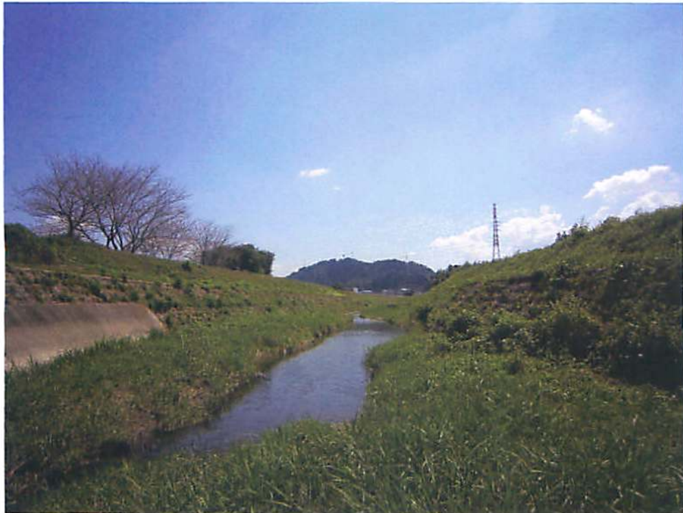
上流部老朽護岸
