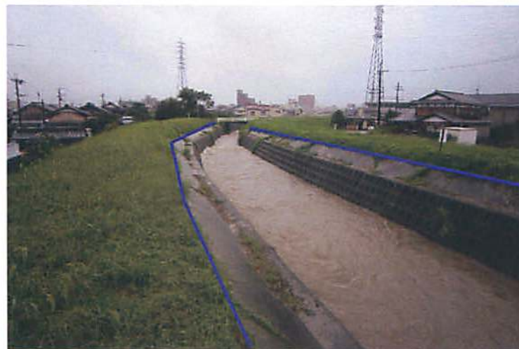
県道六地藏草津線付近(上鈎地先)青線はH16.10.20台風23号での水位
