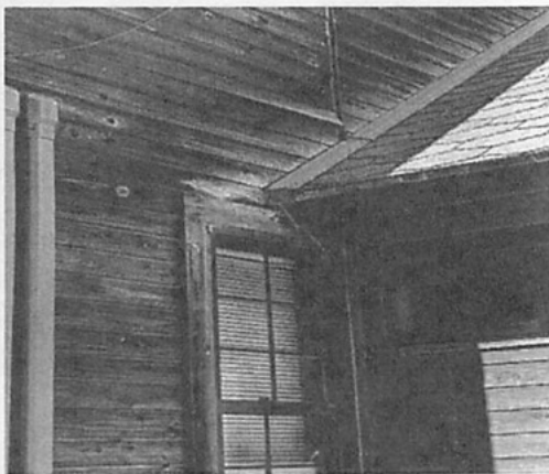
No.10 管理棟外壁
