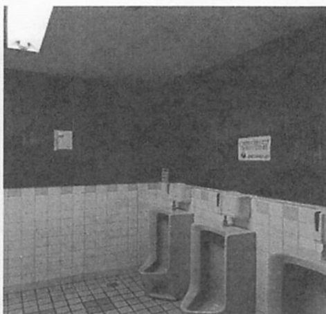
No.16 トイレ壁
