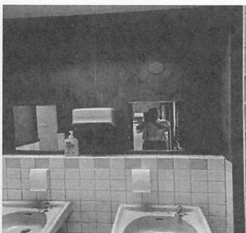
No.15 トイレ壁
